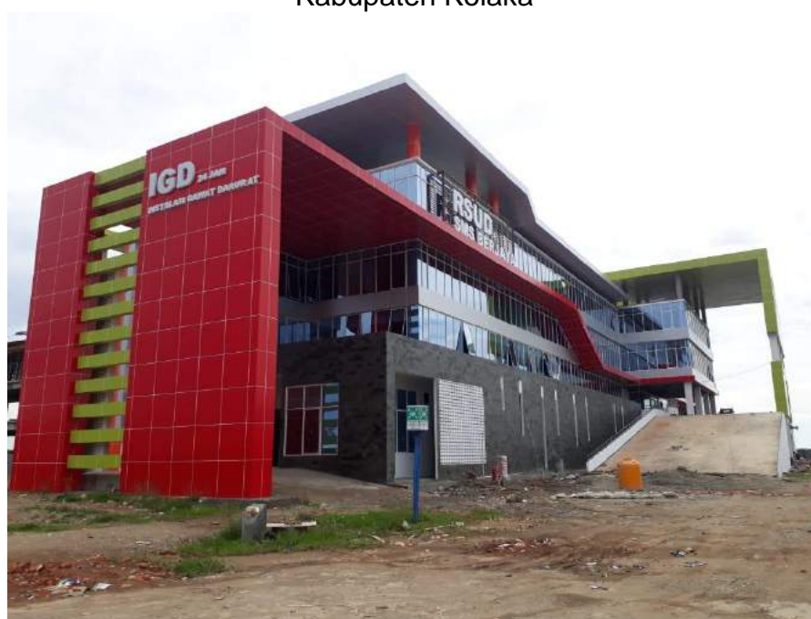
Foto : Tower I RSUD SMS Berjaya Kolaka
