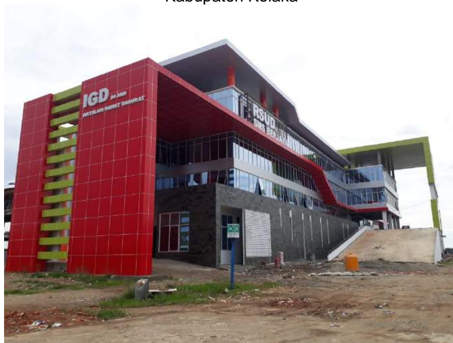
Foto : Tower I RSUD SMS Berjaya Kolaka
