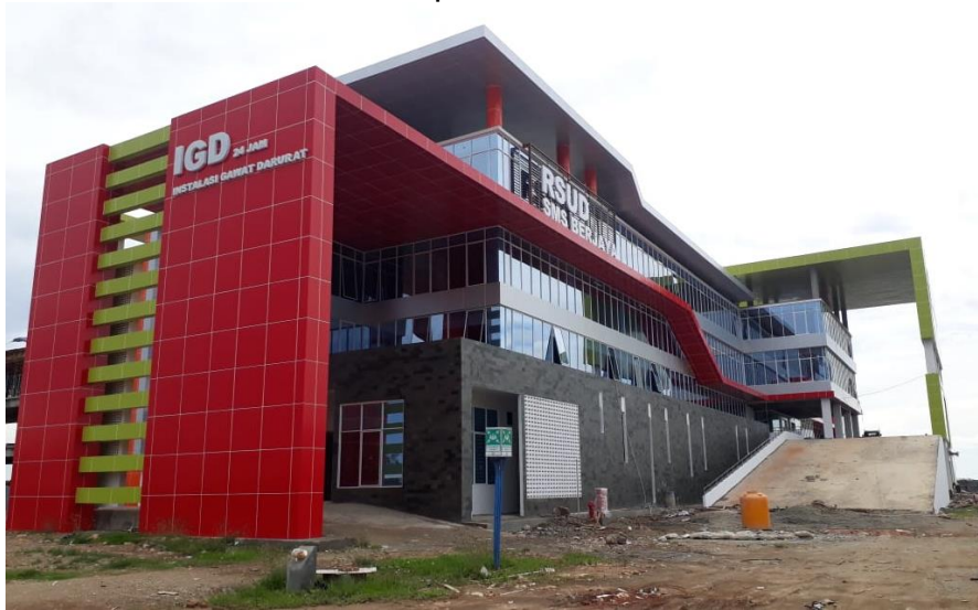
Foto : Tower I RSUD SMS Berjaya Kolaka
