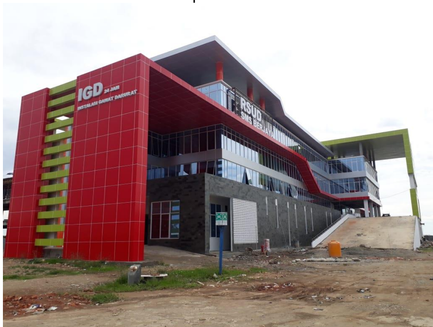
Foto : Tower I RSUD SMS Berjaya Kolaka
